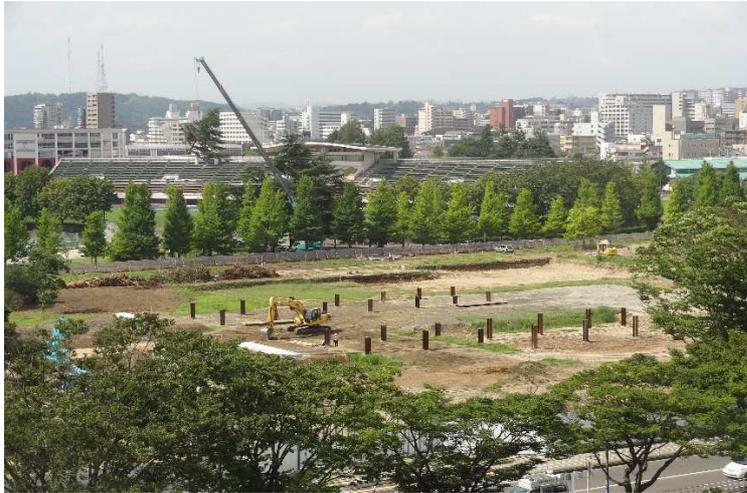
大型クレーン用作業構台足場の設置
